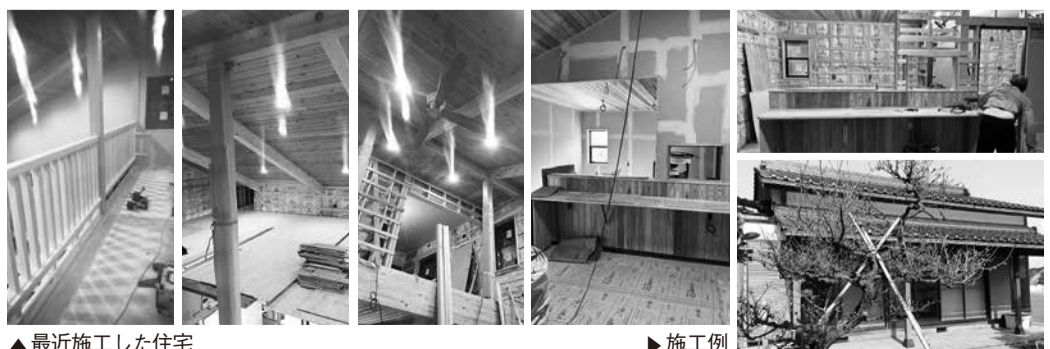
▲最近施工した住宅
