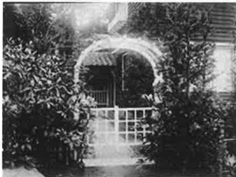
写真6 竣工写真集 2 枚目 洋館と土蔵を繋ぐ渡り廊下
