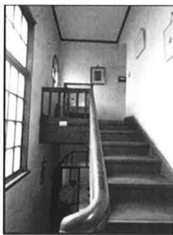
(右)写真 8-2 階段室の現状 踊り場から 2 階まで
